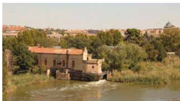
Foto VSI.3. Central Hidroeléctrica de Azumel
